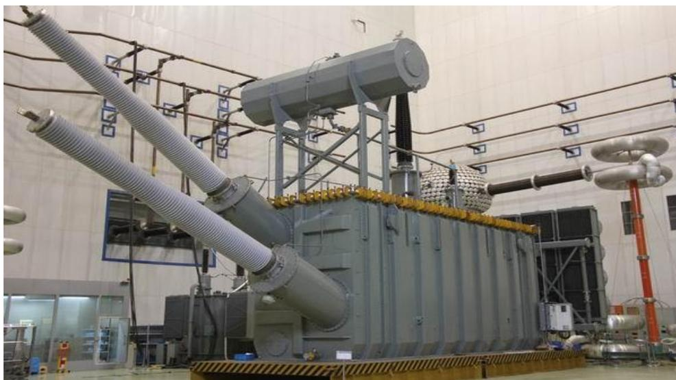
图 2 换流变压器
